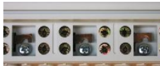
Obr. 4 Propojka rozpojena - zkušební režim
